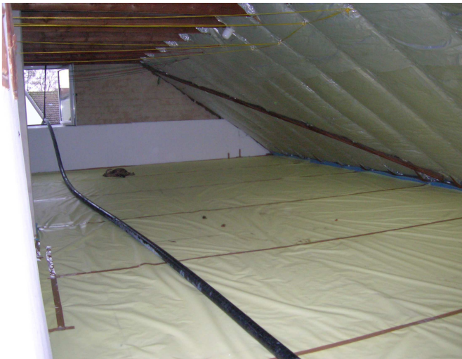
Dämmung der obersten Geschossdecke und des Daches
